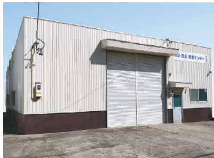
研修センター2号館
