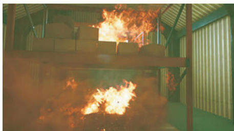
▲溶接作業での火災
