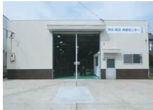
研 修 セ ン タ ー 2 号 館
