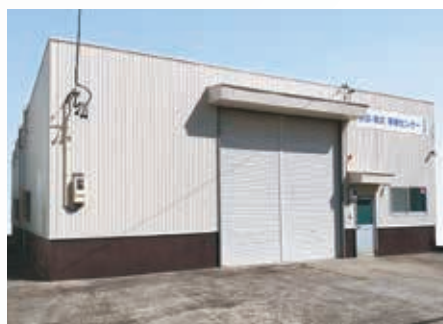
研修センター2号館
